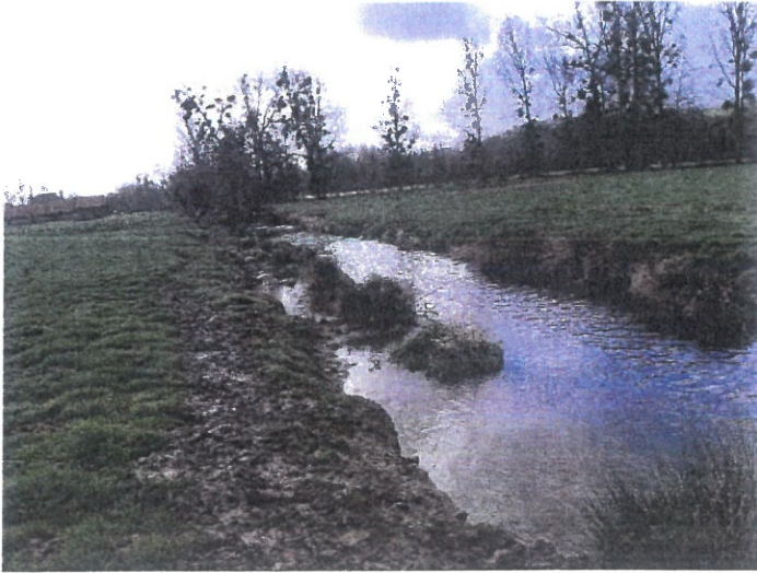
Environnement aval de la zone d'implantation du gué
