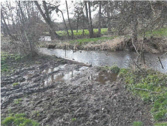
Rive droite du futur gué (vue aval)
